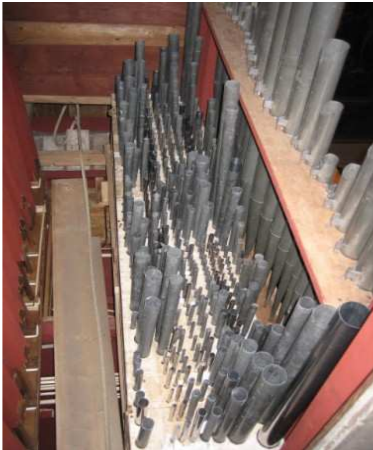
15 Canne interne al termine dei lavori
