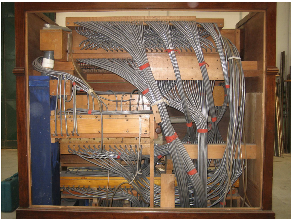
Consolle: vista posteriore, smontaggio in laboratorio
