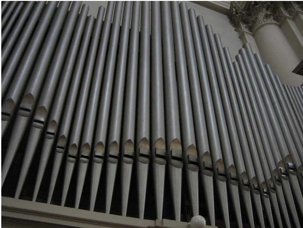
Facciata al termine del restauro: particolare delle bocche riportate delle canne
